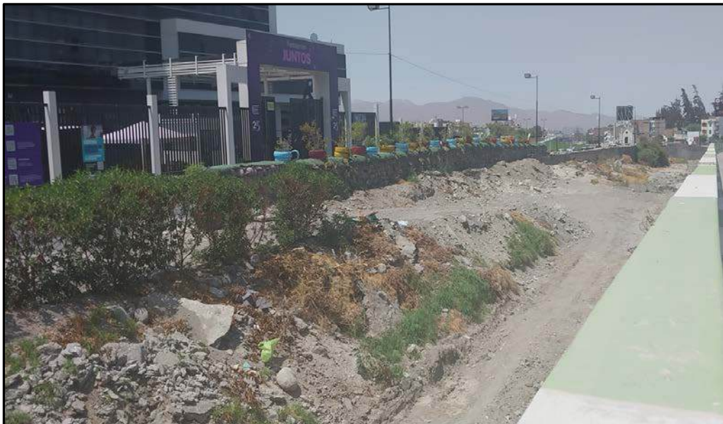
Fotografía N° 2: Vista frontal de ingreso a la Universidad Continental, se observa que el muro de protección existente es muy precario y de baja altura
