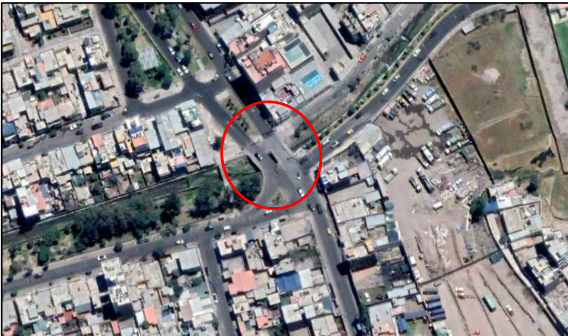
Imagen N° 8: Ubicación del puente Dolores
