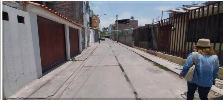
Urb. Los Portales, Implementación de un drenaje pluvial
