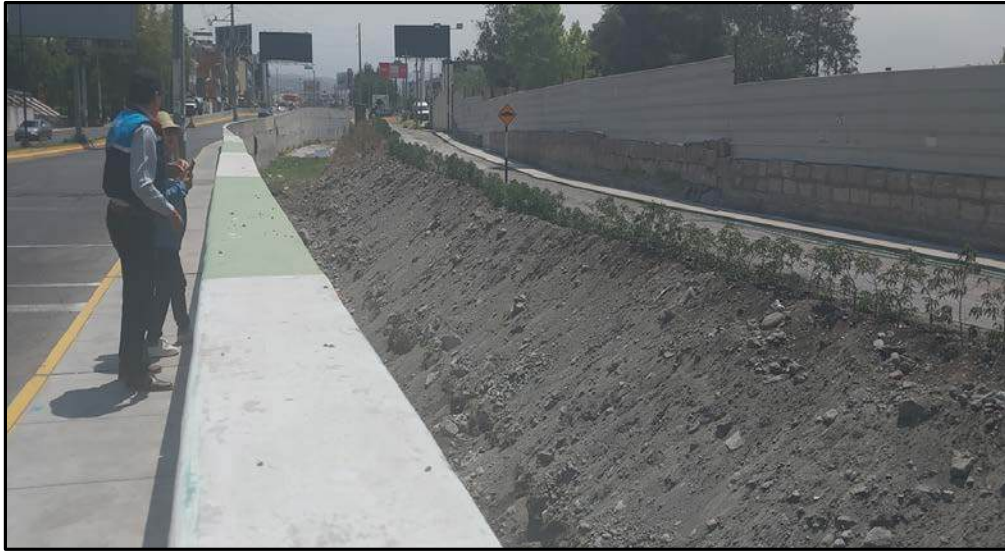
Fotografía N° 2: Vista frontal de ingreso a la Universidad Continental, se observa que el muro de protección existente es muy precario y de baja altura
